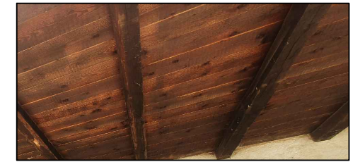
Trattamento delle travi della copertura
