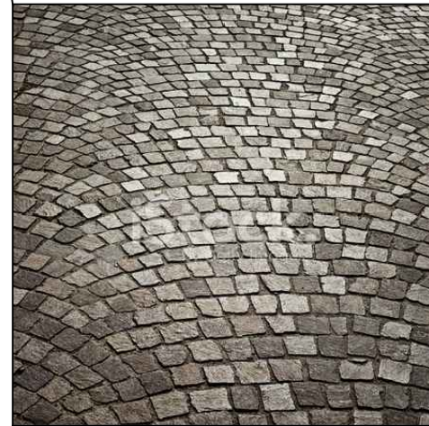
PARTICOLARE PAVIMENTAZIONE IN CUBETTI DI PROFIDO 10X10X12
