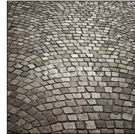
Rifacimento di parte pavimentazione in cubetti di porfido
