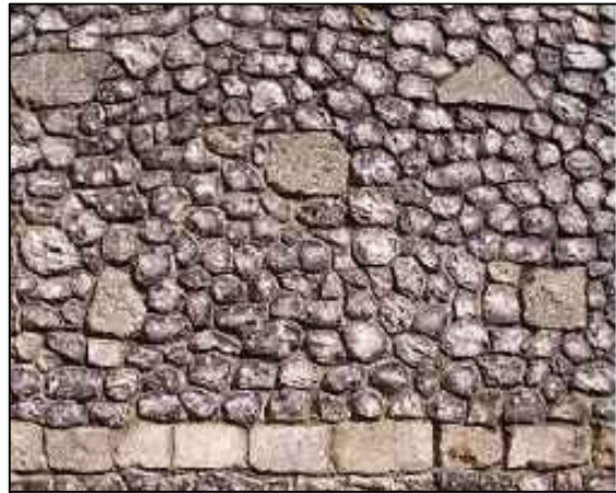
Particolare della muratura in pietra
